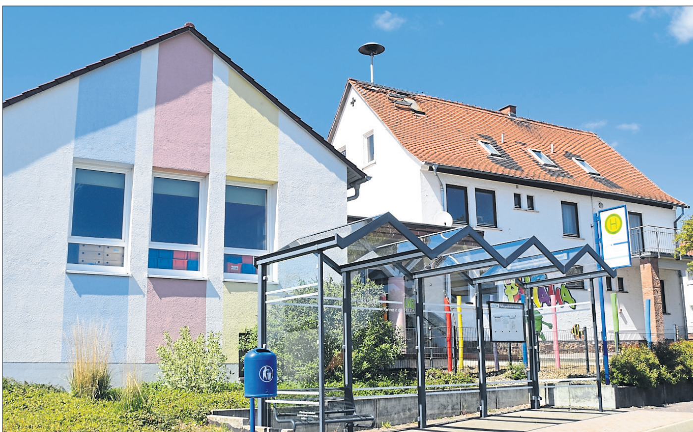
Der Kindergarten Panama nutzt einige Räume im alten Dorfgemeinschaftshaus (rechts) mit. Dieses wird bald abgebrochen, stattdessen wird ein Anbau an die Kita errichtet. Foto: Sabrina Mehler
